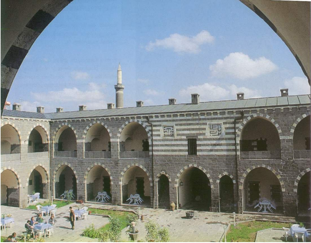
Diyarbakır Deliler Hanı Avlu Revakı
