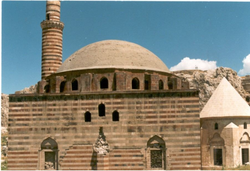
Van Hüseyin Paşa Camii Kible Duvarı
